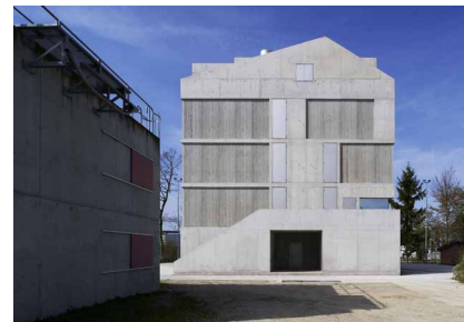
Das Brandhaus II im Ausbildungszentrum Rohwiesen der Zürcher Feuerwehr.
