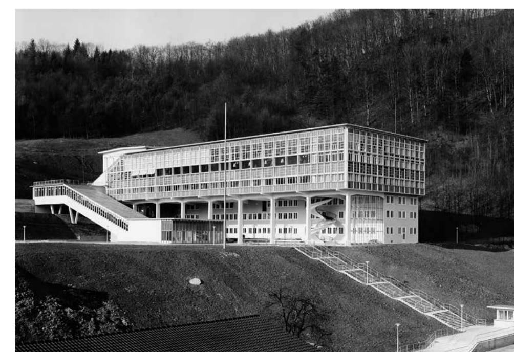
Ursprungsbau: 1954 Wettbewerb Umnutzung: 2002 Bauzeit: 2004–2006 Architektur: Armin Meili, Luzern / Burkard Meyer Architekten BSA Baden Bauherrschaft: Stadt Baden Baukosten: rund 30 Mio. Denkmalschutz: kommunal, Inventar Kulturgüter von nationaler Bedeutung
