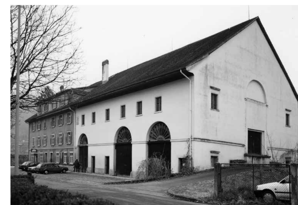
Ursprungsbau: 1836 Wettbewerb Umnutzung: 2002 Bauzeit: 2007–2008 Architektur: :mlzd, Biel Kunst am Bau: Roland Herzog, Schlieren Bauherrschaft: Kanton Aargau Baukosten: 8,4 Mio. Denkmalschutz: kantonale
